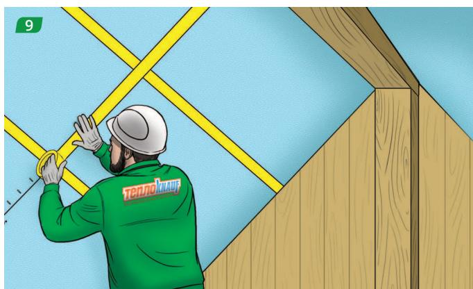
Стыки и места крепления степлером проклеива-ем лентой для заклейки швов.
