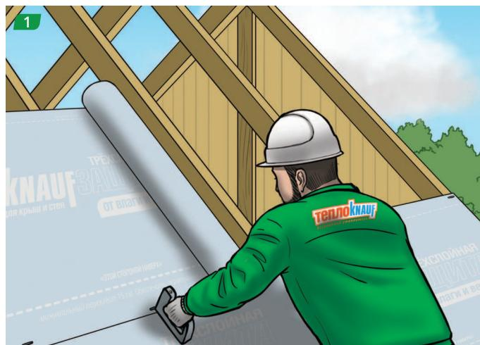
Раскатываем мембрану горизонтально вдоль нижней части стропил и фиксируем по стропилам стеклером.
